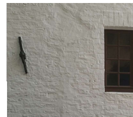
Mauerwerksanker in Nordfassade
