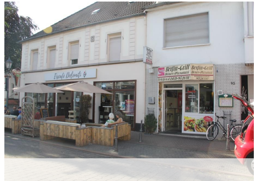
Unattraktive Werbeanlagen / Fassaden
